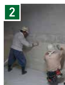
専用接着剤を塗り、高弾性材を貼る
