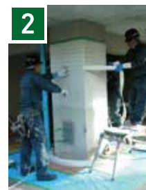
専用接着剤を塗り、高弾性材を巻く
